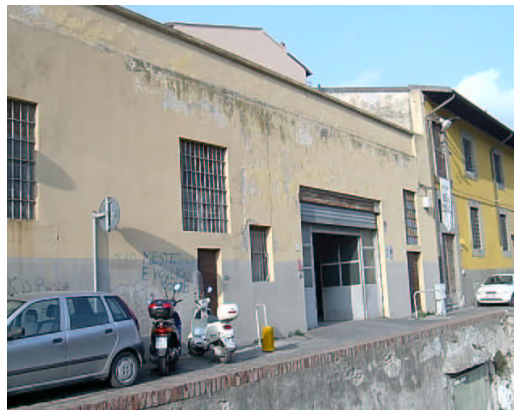
L'edificio sede del garage auto
